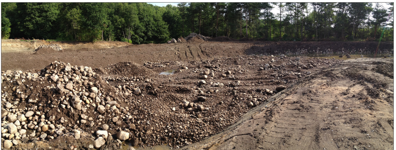
Store vandløb udglatter hurtigt variation. Så udlægningen af grus og sten skal rumme stor form-variation i anlægsfasen. Foto: Klaus Balleby
