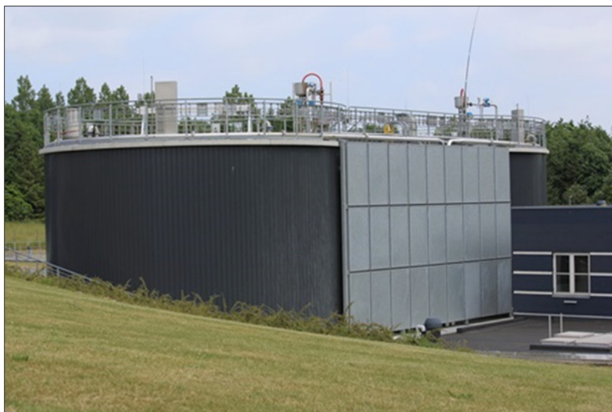
Figur 1: Anammox-anlægget på Ejby Mølle hvor bakterier omsætter ammonium til frit kvælstof (VandCenter Syd)™
