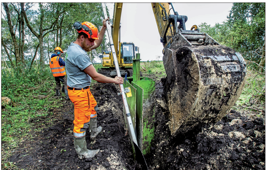
Foto 2: Nedgravning og udrulning af membraner ved hjælp af en specialdesignet membranudlægger (Foto: Anders Ole Olsen, Sjællandske Medier)
