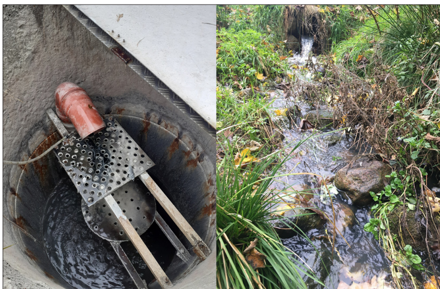
Figur 4. Iltningstrapper ved hhv. filtermatriceanlægget ved Skovlyvej (tv), og minivådområdet Jordrup (th), som viser et typisk eksempel på hvordan iltningstrapper i minivådområder er konstrueret.
