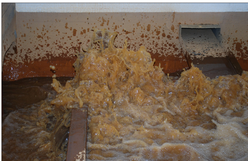
Foto 2. Ujævnt skyl med luft og vand, hvor skyllevandet plasker ud i skyllevandsrenden i bagenden af et gravitationsfilter.
