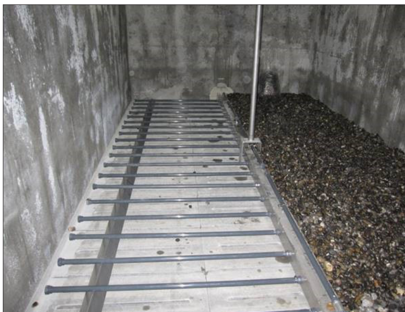
Foto 3. Eksempel på en bjælkebund (venstre) og en dysebund (højre).
