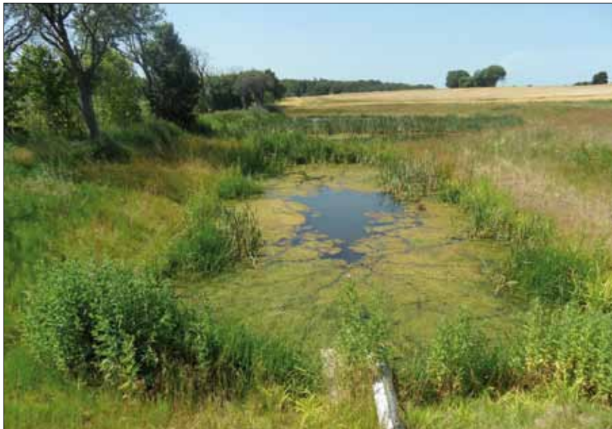
Figur 5. Konstrueret minivådområde med overfladestrømning bestående af sedimentationsbassin (ses forrest), og vådområde med skiftevis dybe zoner og lavvandede vegetationszoner. Minivådområdet, der er etableret i en lavning i udkanten af marken, er på 0,35 ha og modtager drænvand fra ca. 50 ha landbrugsareal. Foto: Charlotte Kjærgaard.
