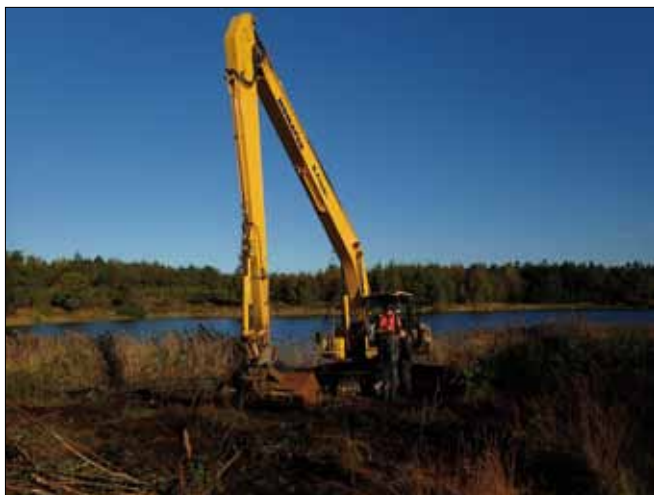
Fig. 4. Gravemaskine med åben skovl til afgravning af rørskov og senere afretning af brinker.
