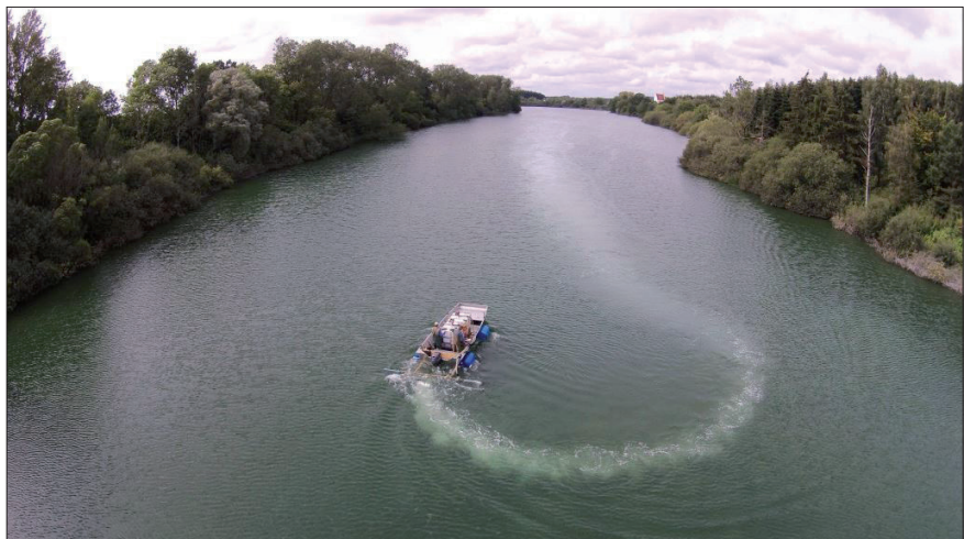
Figur 1. Udbringning af aluminium i Sørup Sø, Svendborg 2015. Bemærk den tydelige fane af udfældet \text{Al}(\text{OH})_3 efter båden. Foto Nils Mogensen Svalebog, Fyns Amtsavis.
