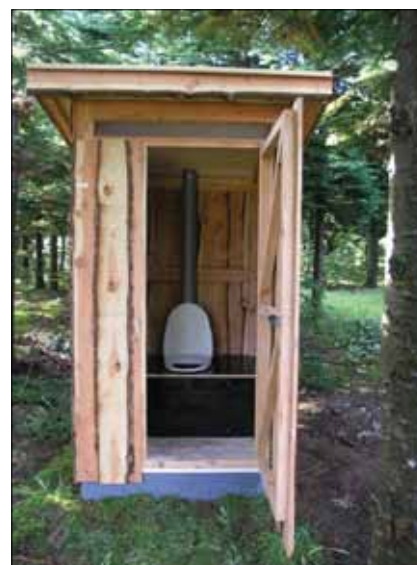
Figur 2. Vandfrit multitoilet. Velegnet til kvinder (og mænd). Men udformningen egner sig ikke til installation i lufthavne.
