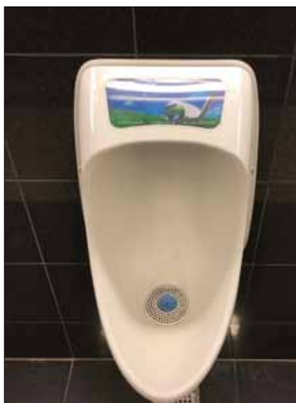
Figur 1. Vandfrit urinal, Kastrup Lufthavn
