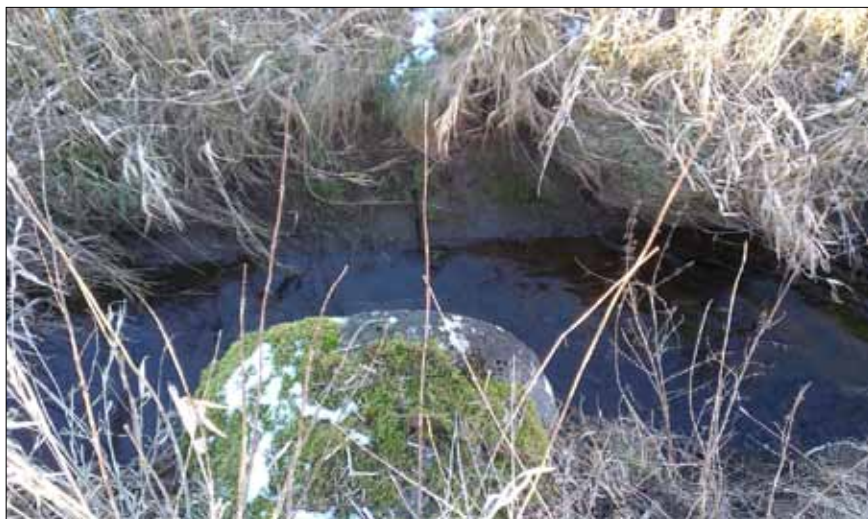
Figur 1. Uforsinket udløb fra regnvandsledning i separatkloakeret opland. Over for udløbet er der etableret brinksikring for at afværge erosion. Bemærk, at rørets diameter er næsten lige så stor som vandløbets bredde. Foto: Rikke Bjerg.
