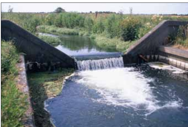
Figur 12. Styrt i tusindvis blev bygget i vore udrettede åer, så strømmen kunne omdanne sine erosionskræfter til varme på en betonplade. Nu er de udskiftet med stryg og mæandre.
