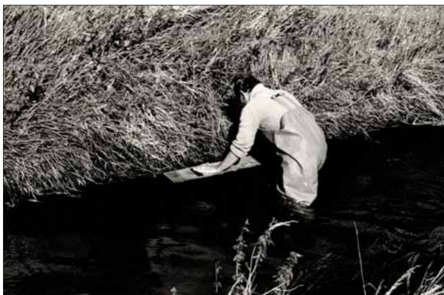
Figur 10: Sådan begyndte vandløbsrestaurering i Voer Å: Åmanden laver halvtag, som ørrederne kan søge ly under. Og det virkede.
