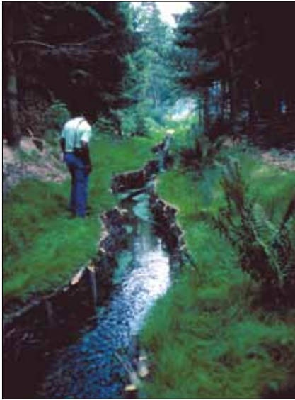
Figur 11: Engagerede studenter fra Ingeniørhøjskolen i Horsens indsnævrede den brede, sandfyldte bæk med faskiner: Sø-ørrederne kom igen. På et Unesco-kursus kritiserede Chris fra Zimbabwe projektet: I mit land ville termitterne have spist faskinerne på et døgn.
