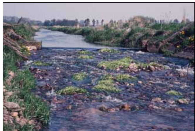
Figur 12. Styrt i tusindvis blev bygget i vore udrettede åer, så strømmen kunne omdanne sine erosionskræfter til varme på en betonplade. Nu er de udskiftet med stryg og mæandre.
