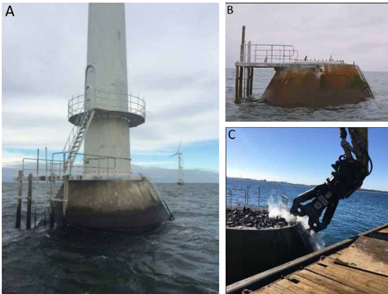
Figur 2. Fjernelse af verdens første havvindmølle park, der stod ved Vindeby på Lolland i perioden 1991 – 2017. Fundamenterne rummede ingen miljøfarlige stoffer /9/. Hvert fundament var et gravitationsfundament og havde en top-diameter på 5 m og en bund-diameter på 14 m. Fundamenterne blev bl.a. fjernet med en hydraulisk betonsaks. Fjernelsen af fundamenterne kostede ifølge Ørsted A/S et mindre tocifret millionbeløb. Billede A er fra /9/ og B og C er taget af Ørsted A/S.
