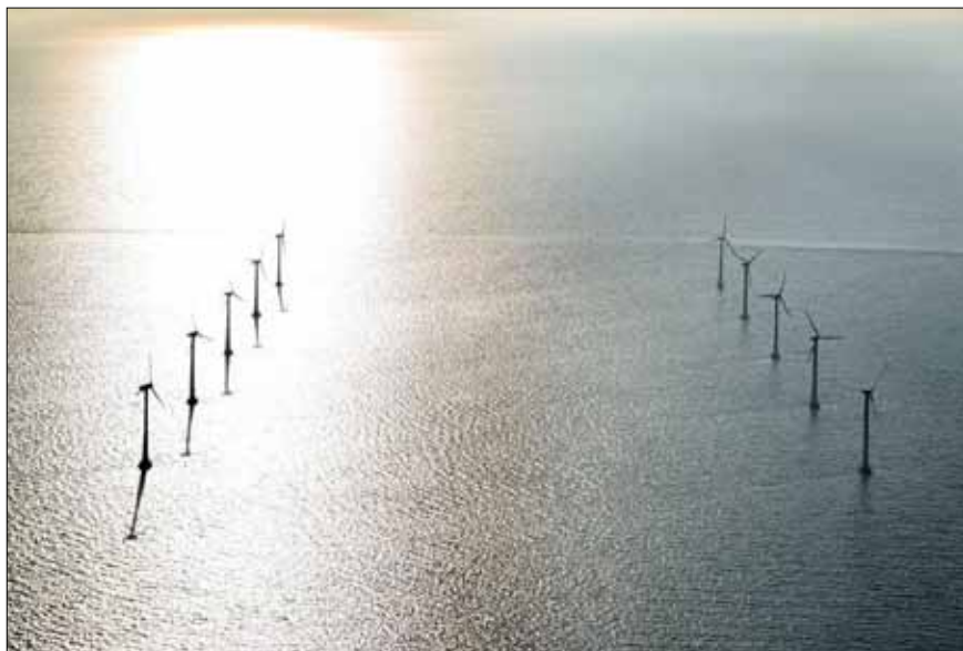
Fig. 5. Vindmøller ved Tunø Knob Havmøllepark. Parken er fra 1995 og vil forventeligt blive nedtaget og fjernet de kommende år. Der er tale om gravitationsfundamenter på vanddybder mellem 4 og 7 m. De 10 fundamenter fungerer sandsynligvis som marine rev, der giver levesteder til mange organismer. Det vil derfor være fordelagtigt at beskrive den økologiske funktion af fundamentene og undersøge, om det er muligt kun at fjerne hvert fundament delvist og lade resten fungere som et rev. Billedet er taget af MHI Vestas Offshore Wind.
