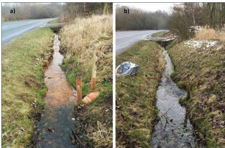
Figur 1: Billeder af udløbet fra rodzoneanlægget til vejgrøften hhv. a) før rodzoneanlægget blev etableret og man tydeligt ser tegn på okkerudfældning (foto: Laust Hvidtfeldt Lorentzen, d. 3/3-16), og b) efter etableringen uden tydelig tegn på okkerudfældning (foto: Jennie Bjerring Madsen, d. 7/3-18).
