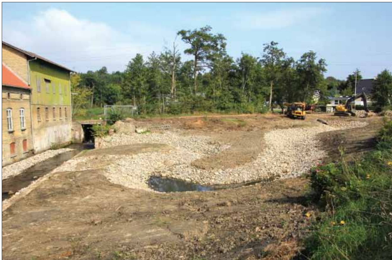
Figur 3: I 2014 etablerede Kolding Kommune et stryg i Gudstø Mølleå, der har sikret fri passage ved opstemningen ved Gudstø Mølle. Foto: Sten Bøgild Frandsen.
