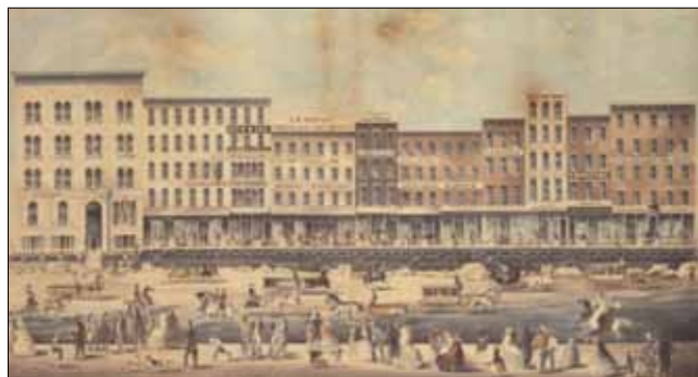
Denne bygning på Lakestreet blev løftet 1,5 meter, mens forretningerne holdt åbent.
