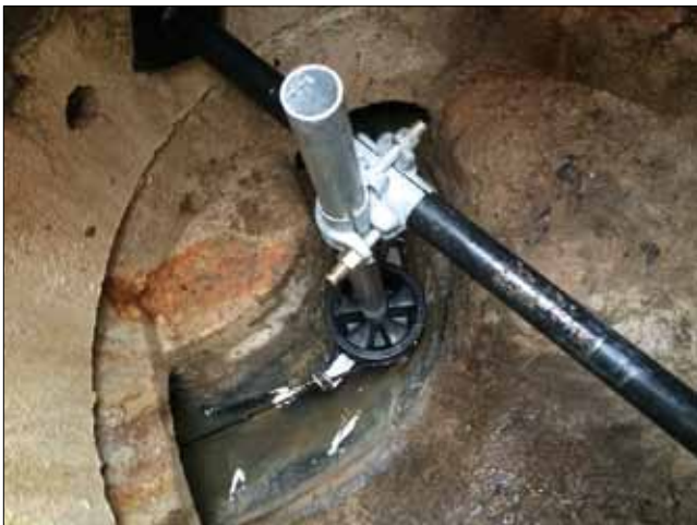
Figur 3. Kabelguider til at komme omkring skarpe retningsændringer (til venstre) og oprinkning med splidset kabel (til højre).
