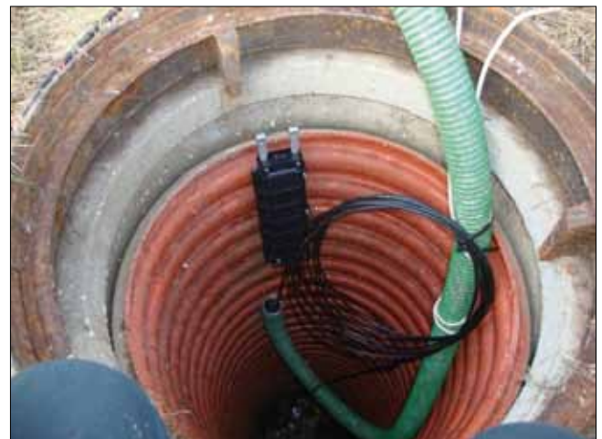
Figur 3. Kabelguider til at komme omkring skarpe retningsændringer (til venstre) og oprinkning med splidset kabel (til højre).
