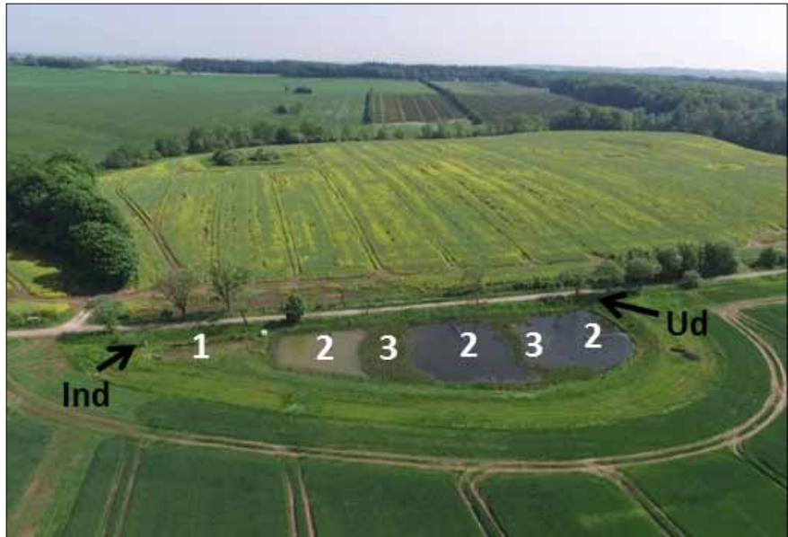
Figur 2. Minivådområdet ved Fillerup med indløb, sedimentationsbassin (1) dybe åbne zoner (2), lavvandede vegetationszoner (3) og udløb. Dronefoto: SEGES.
