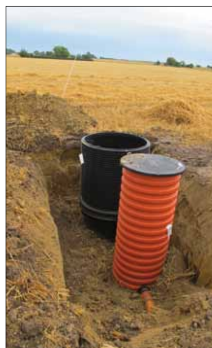
Foto 3. Hedemarksvej, etablering af målebånd og styringsbånd. August 2012
