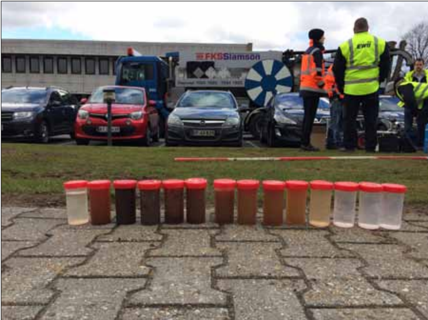
Figur 3. Is- og vandprøver udtaget for hver 30 sekunder (venstre mod højre) fra afgang under Ice Pigging, Venusvej, Fredericia.
