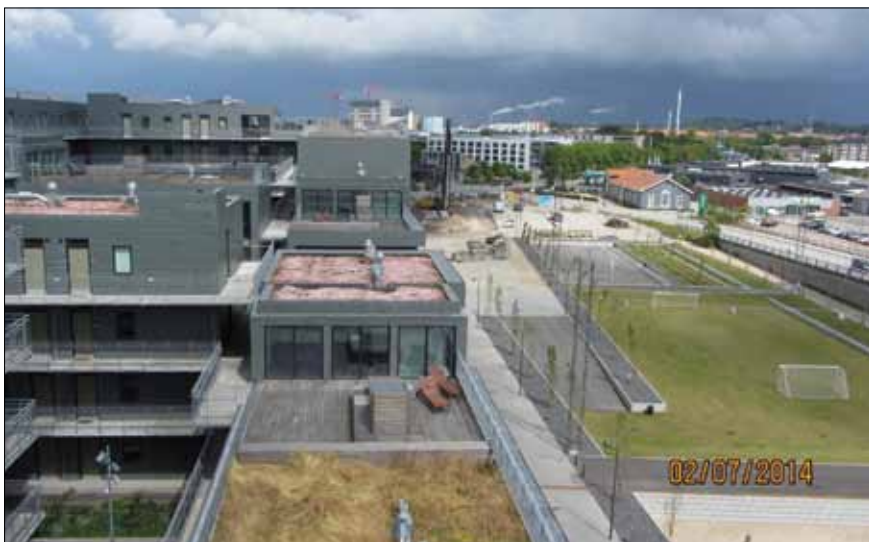
Figur 6: Grønne tage på Godsbanen indgår også i området LAR (Lokal Afledning af Regnvand) løsning. Til højre i billedet ses områdets boldbaner, som i ekstreme nedbørssituationer fungerer som regnvandsbassiner (Foto: Aalborg Kommune).
