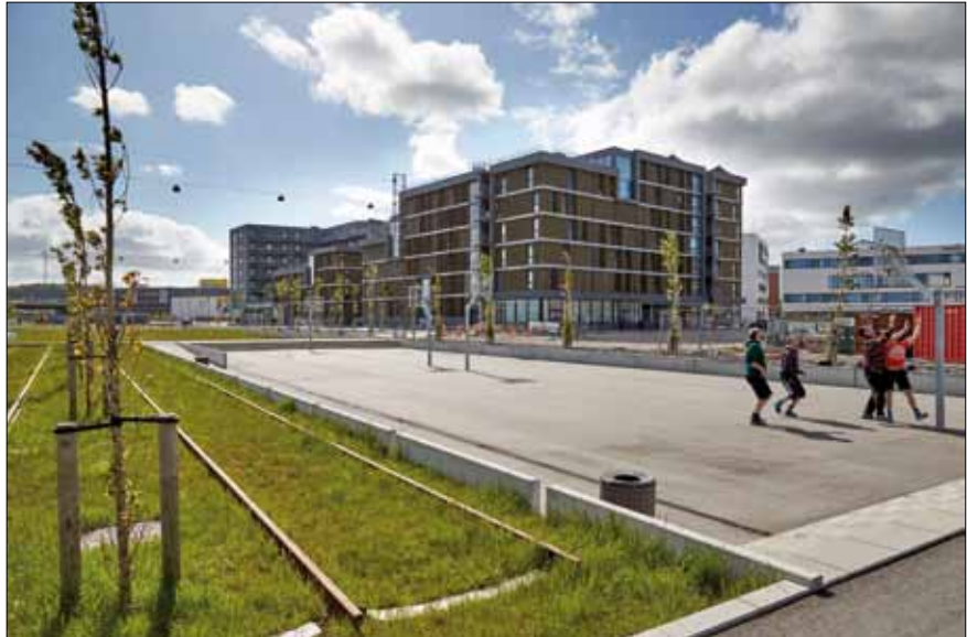
Figur 4: Godsbanens nye udtryk, hvor arkitektur, klimatilpasning og rekreativitet kombineres. Basketball banen fungerer i ekstreme nedbørssituationer som et regnvandsbassin. De gamle jernbaneskinne er genbrugt til at understøtte områdets historiske udtryk (Foto: NIRAS).
