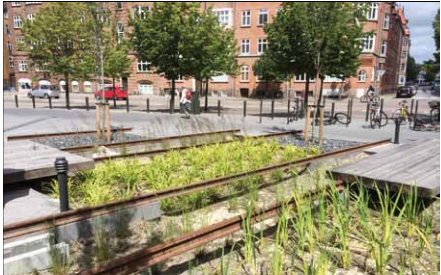
Figur 7: Regnbede på Godsbanen. Regnbedene er etableret med overløb til en rørledning ned i parkarealet, hvor vandet via kanaler ledes ud på boldbanerne (Foto: NIRAS).
