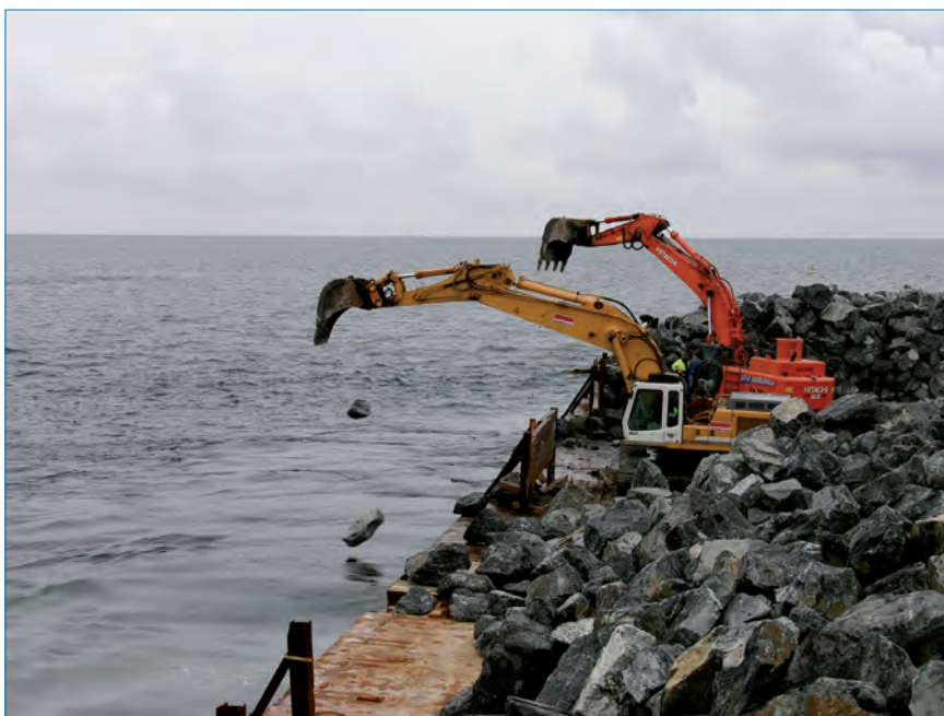
Figur 3. Etablering af Blue Reef i 2008. Pram med gravkøer i gang med at udlægge sten. Der blev udlagt i alt 100.000 tons norske sprængsten. Foto: Else Marie Stamphøj.
